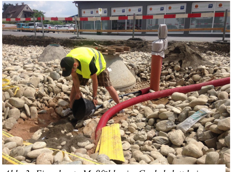
Abb. 3: Eingebaute Meßfühler im Grobskelett beim Radwegprojekt Gradnerstraße in Graz
